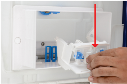
Screw Working Plate کو اتار دیں۔
